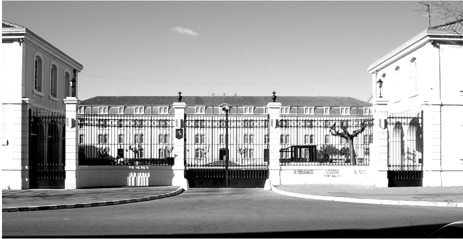
Figure VI. 16 : Portail d'entrée de la caserne, considéré perméable dans le calcul du Cas 1C (Photo prise en mars 2005).
