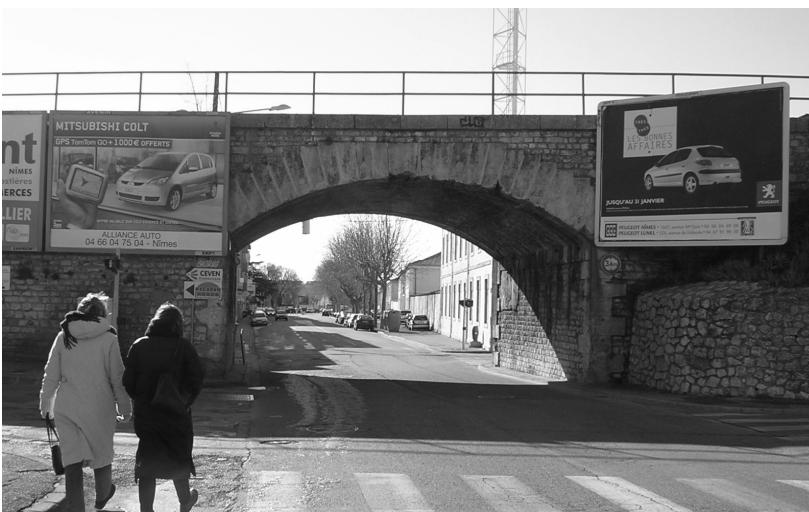
Figure VI. 2 : Passage sous le remblai amont constituant l'entrée Est du domaine (Photo prise en mars 2005).
