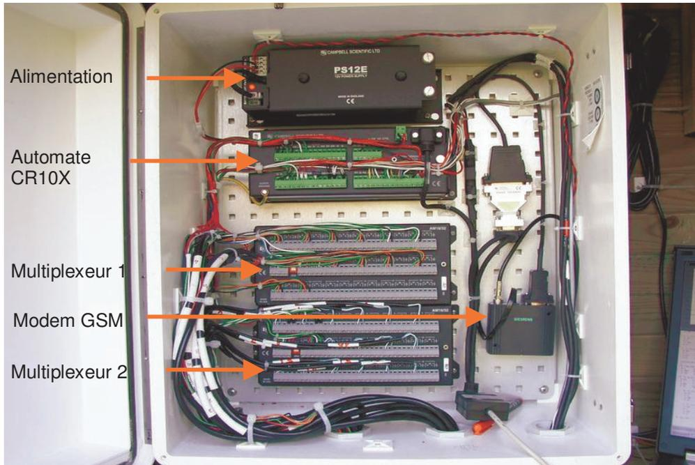
Figure VI.19 : Photographie du coffret de câblage.
