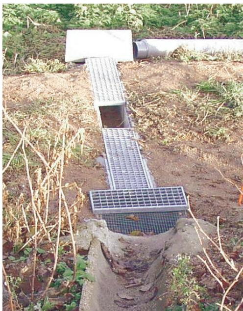
**Figure II.13 : Photographie de la rigole sortant de la vigne et des deux regards faisant office de piège à particules en amont de la canalisation en PVC.**
