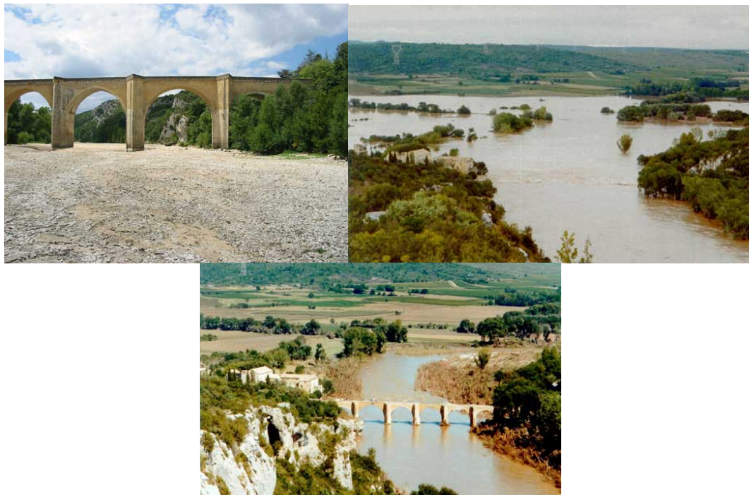
Photo 2 : Pont de saint Nicolas, à l'étiage en août 2002, inondé et après inondation en septembre 2002 – Source : http://www.les-gardons.com/ - Crédit : SMAGE et conseil général du Gard
