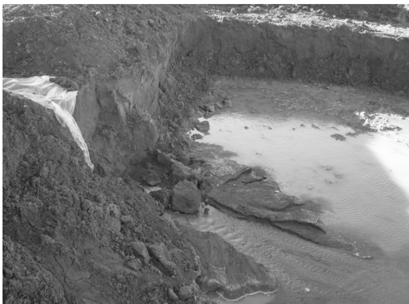
Figure 74. Bassin d'eau en terre en cours de remplissage utilisé par les locataires.
