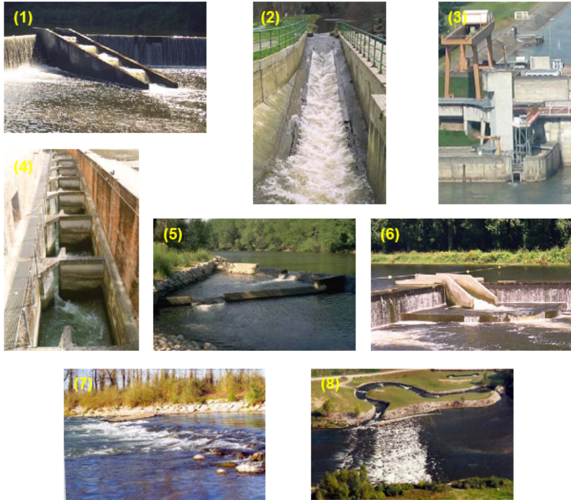
Figure 39 : Illustration des différents types de passe à poissons installées au niveau des obstacles étudiés : (1) passe à bassins à jet plongeant, (2) passe à ralentisseurs, (3) ascenseur, (4) passe à bassins à jet de surface, (5) prébarrages, (6) passe à ralentisseurs avec prébarrage, (7) seuil potentiellement franchissable (le cliché représente ici le seul véritable seuil franchissable par conception) et (8) rivière de contournement.
