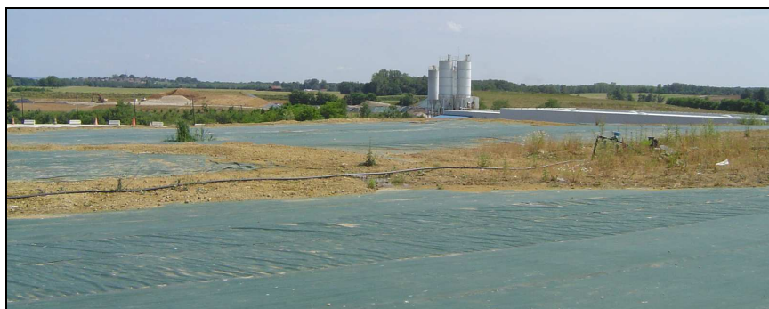
Centre d'ISDND-bioactive en France (pilote témoin et pilote test sont séparés par une couche d'argile)
