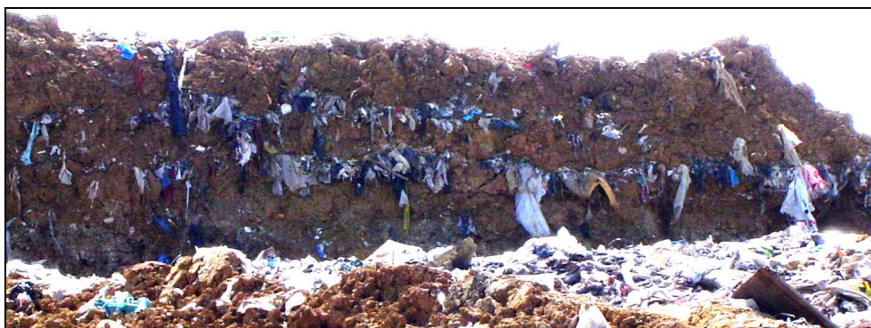
Les couches de déchets stockés et de couverture d'argile
