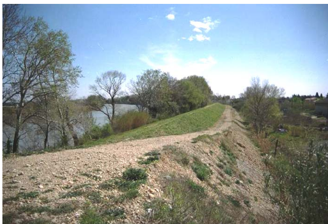
Figure IV.11 : Recharge aval drainante (Digue de Camargue)
