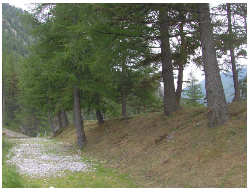
Photo II.5 : Digue de fermeture du barrage de Castérino
