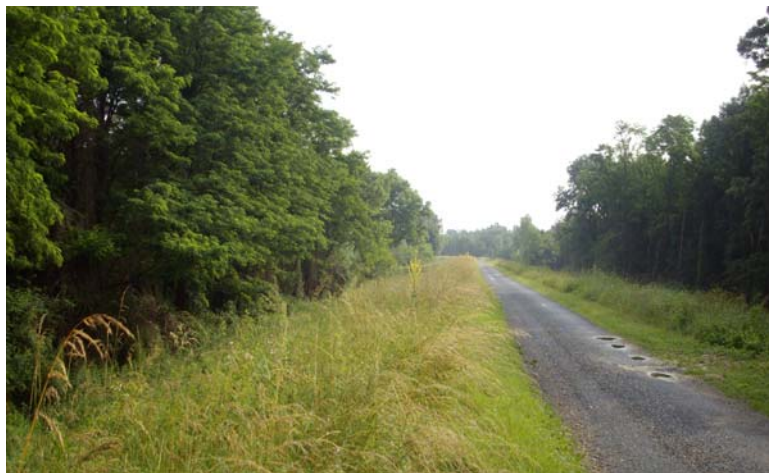
Photo II.4 : Levée de la Loire à Cosne-sur-Loire
