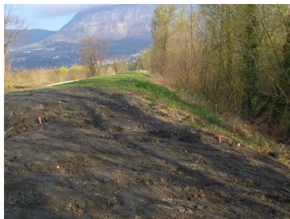
Photo II.19 : Reconstitution du talus de digue
