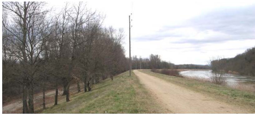
Photo II.2 : Digue du canal du Rhône à Lyon (RD)
