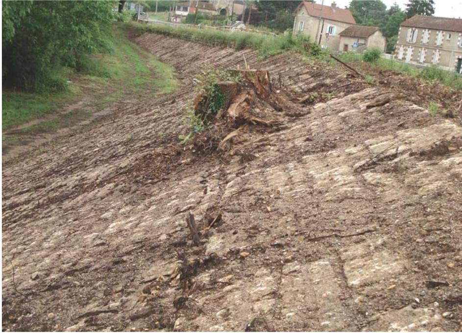
**Figure IV.1 : Colonisation par des racines d'arbre d'un joint ouvert de perré maçonné - amorces de déstructuration (Levée de la Loire)**
