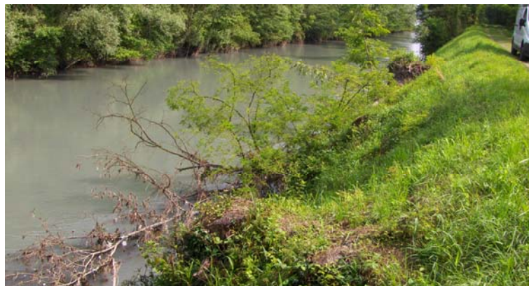
Figure IV.7 : Renversement d'un robinier sur le talus côté rivière (Digue de l'Isère)
