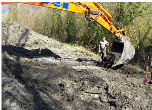
Photo II.18 : Remblaiement de la zone
