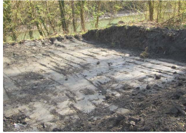
Photo II.13 : Terrassement de la zone expérimentale
