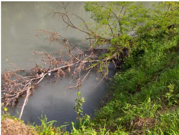
**Figure IV.8 : Affouillement du pied de digue par des courants tourbillonnaires (Digue de l'Isère)**
