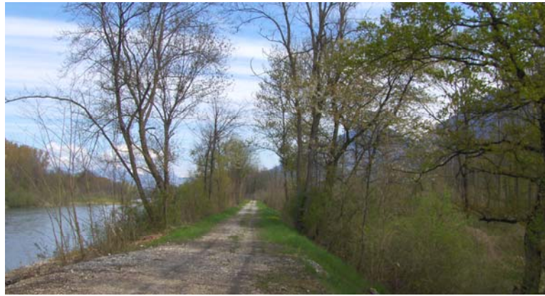
Photo II.3 : Digue de l'Isère à Tencin
