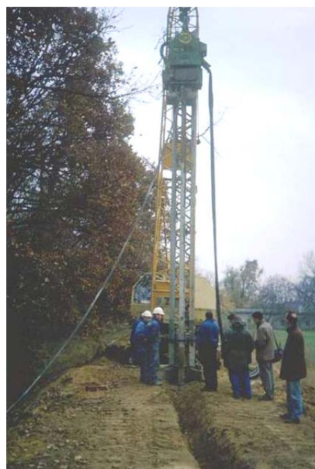
Figure IV.12 : Réalisation d'une paroi moulée (Digue en Pologne)
