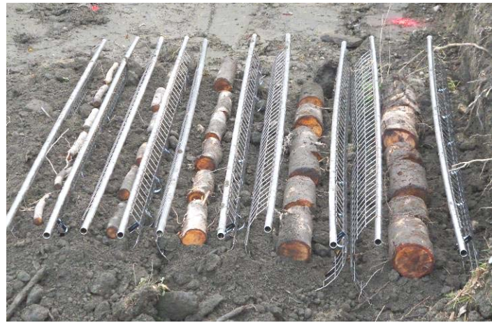
Photo II.15 : Mise en place des paniers
