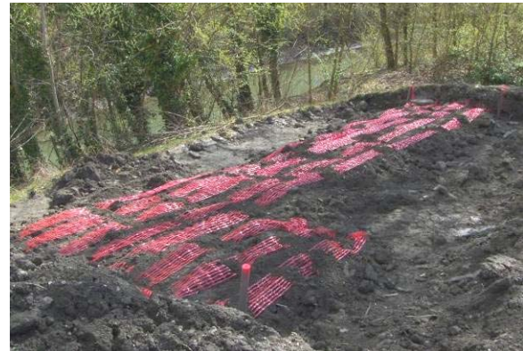
Photo II.17 : Mise en place du grillage avertisseur
