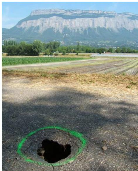
**Figure IV.4 : Effondrement en crête de digue lié à la décomposition d'une souche (Digue de l'Isère)**
