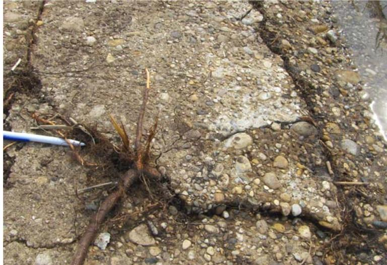
**Figure IV.3 : Dégradation du perré par colonisation d'une fissure par les racines (digue de canal du Rhône)**
