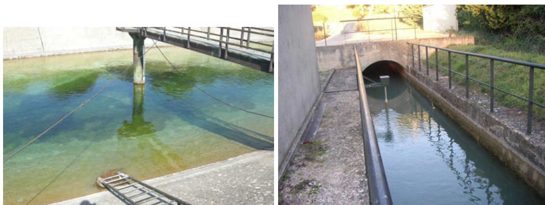
(a) Capteur hydraulique de niveau, canal de Provence, Pourcieux
