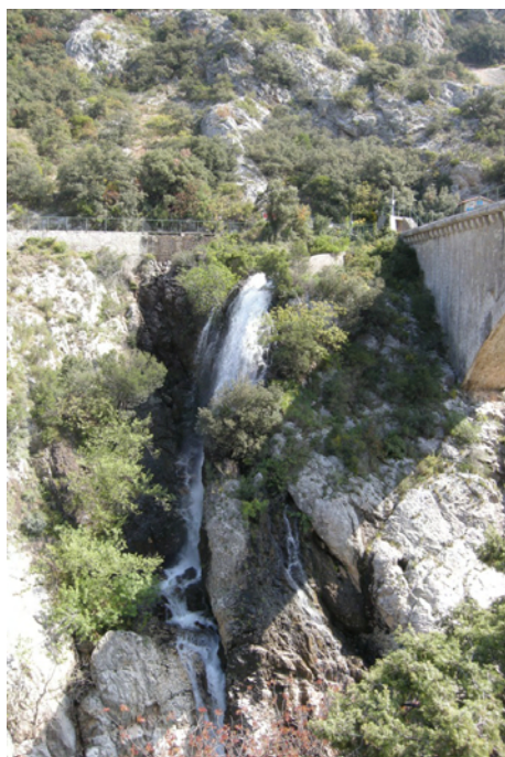
(c) Décharge d'eau turbide sur la station du Partiteur
