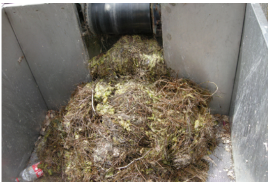
(c) Rejet d'un dégrilleur automatique, canal de Provence
