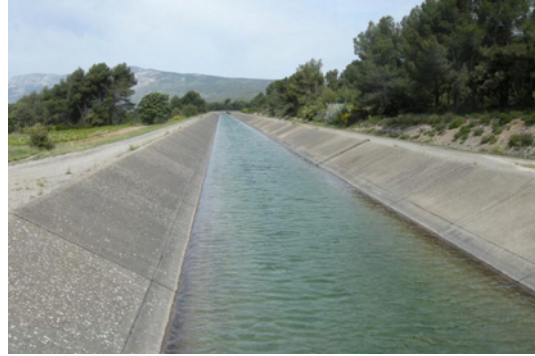
(b) Branche du Var, canal de Provence
