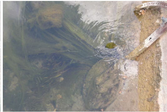
(b) Filaments algaux dans une prise latérale, canal de Gignac
