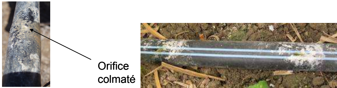
Figure I-19 : Exemple de colmatage par précipitation de \text{CaCO}_3 , et son amorce sur une gaine
