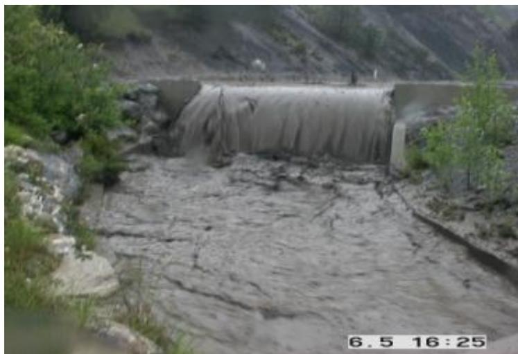
Figure 6.9. Déversement au barrage de la plage de dépôt à l'exutoire du Laval lors de la crue du 5 juin 2003 (Cliché : N. Mathys)
