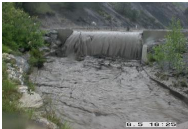
Figure 6.9. Déversement au barrage de la plage de dépôt à l'exutoire du Laval lors de la crue du 5 juin 2003 (Cliché : N. Mathys)
