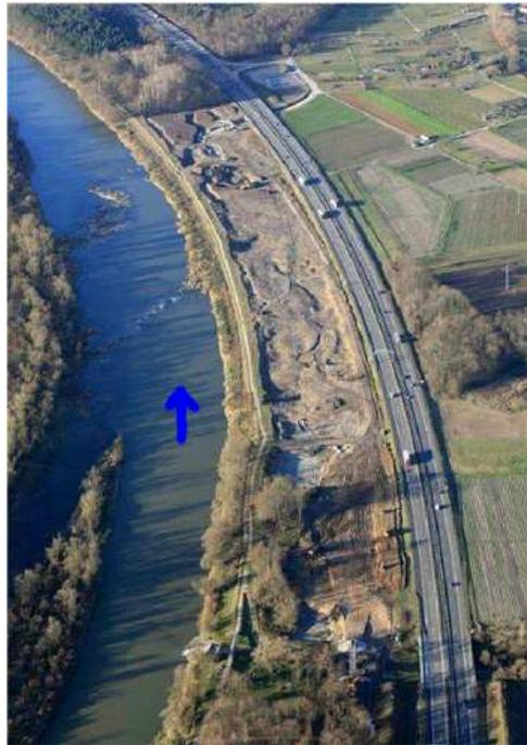
FIGURE 1.15 – Photographie aérienne des travaux de décaissement IRP dans la section I. La flèche bleue indique le sens d'écoulement (Source : Regierungspräsidium Freiburg)
