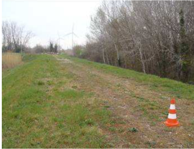
Figure 10-4 : Vue du profil de digue n°1
