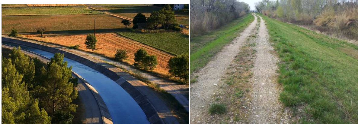
Figure 2-2 : A gauche, digue sur le canal de Provence, en charge permanente, à droite digue du Rhône, à sec en situation normale d'exploitation
