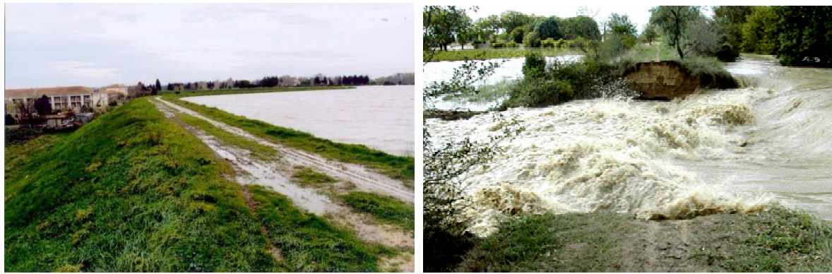
Figure 2-7 : Digue du bas Rhône lors d'une crue importante (crue d'occurrence centennale) et rupture de digue sur le Vidourle (30) en septembre 2002
