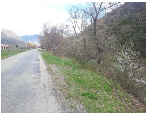
Figure 11-6 : Vue générale du tronçon n°4
