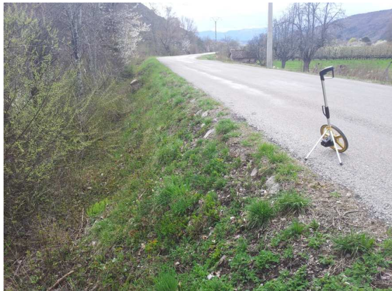
Figure 11-3 : Section courante de la digue, route départementale en crête et végétation importante sur le talus côté rivière (gauche de la photo)
