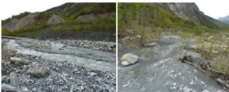
FIGURE 6.20 – Photographies prises sur le site D1 en mission de reconnaissance
