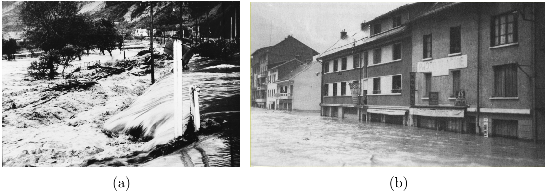
FIGURE 3.3 – (a) Rupture de digue causée par la crue de l'Arc de juin 1957 (b) Inondation dans une rue de Modane (source photos : Rail Savoie)
