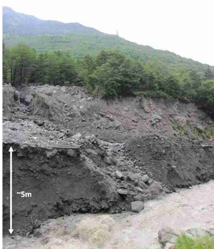
FIGURE 1.1 – Confluence de l'Arc avec le torrent du Pousset : érosion du cône de déjection du torrent lors de la crue du 21 juin 2013 (photo P. Negrello)
