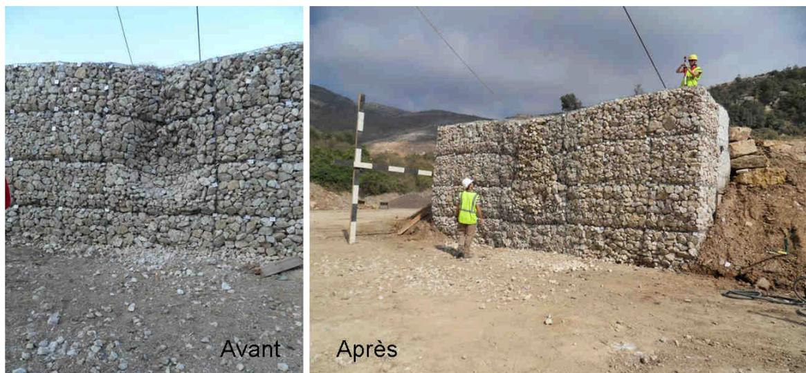
FIGURE 5.2 – Aspect du parement avant et après réparation par la mise en place d'une rustine de grillage.
