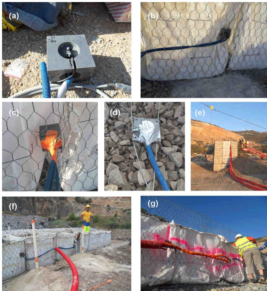
FIGURE 2.26 – Mise en œuvre des accéléromètres pour les expérimentations à échelle réelle.
