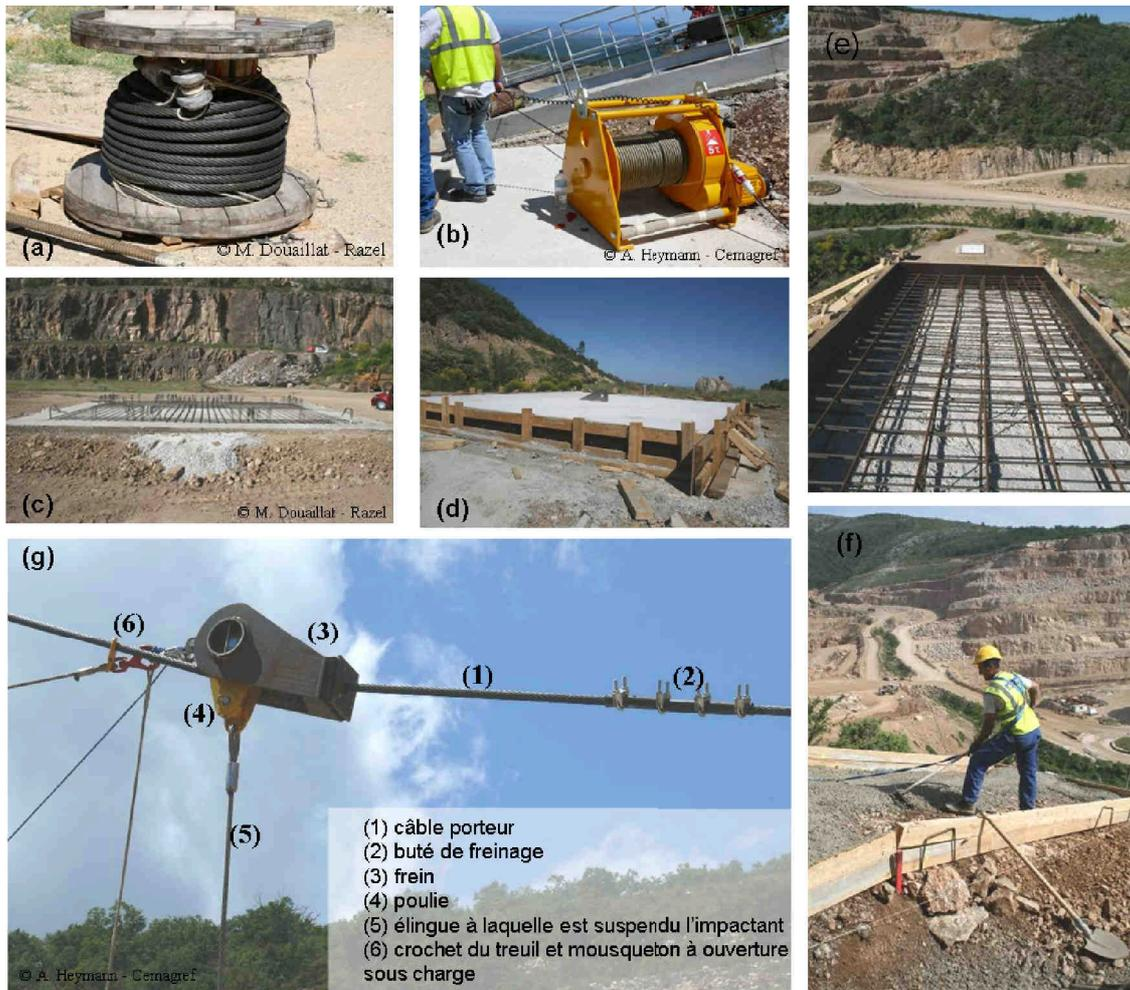
FIGURE 2.9 – Photographies des composants du système de lancement.
