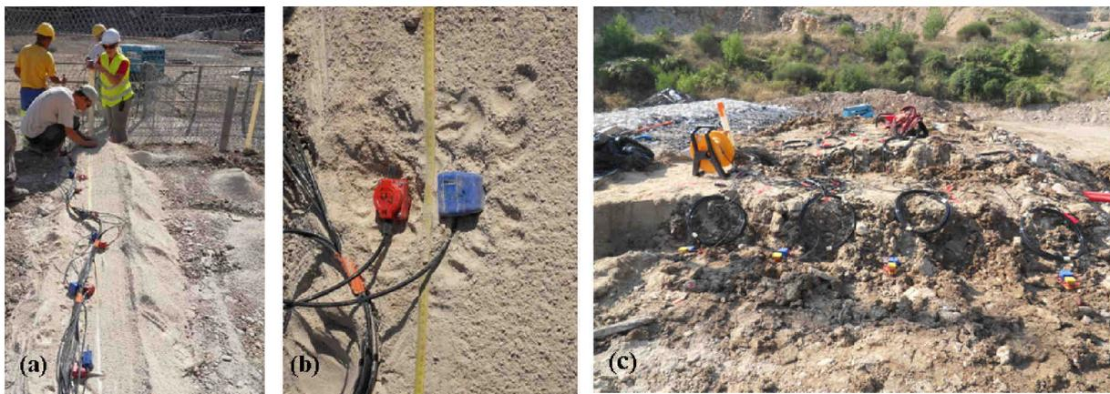
FIGURE 2.19 – Mise en place des géophones dans le remblai de l'ouvrage 1 (essais à échelle réelle), (a) lit de sable aplani pour permettre un meilleur positionnement, (b) géophone vertical (rouge) et horizontal (bleu), (c) positionnement des géophones de surface.
