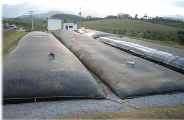
Figure II-18 Quatre géotubes remplis de boues de station d'épuration en cours d'égouttage. (Castro et al., 2008).
