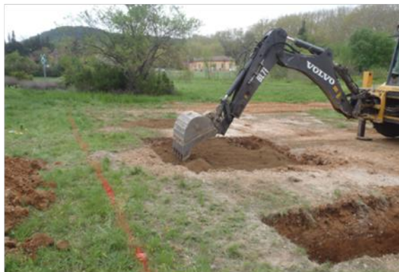
(b) Décaissement des placettes sur 1 m de profondeur et remblayage par un matériau fin de façon homogène
