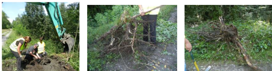
FIGURE 4.1 – Dessouchage d'une souche de frêne implantée sur la digue de l'Isère ; photographies Daniel Bambara
