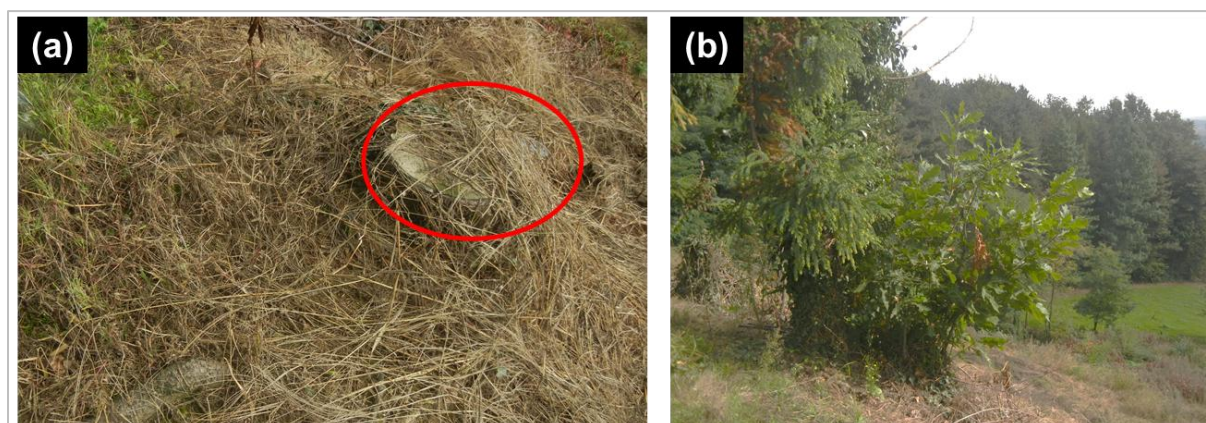
Figure 97. Souche de conifère morte (a) et souche de chêne ayant rejeté (b) sur le couronnement aval du barrage de Grengia, Italie (photo : Bambara G., 2014)
