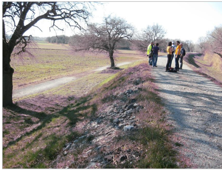
Figure 113. Photo de la digue rive gauche du Petit Rhône dans le secteur du Bois de Beaumont. Vue de la végétation arborescente présente en pied de digue côté zone protégée (Photo : Bambara G., 2015)
