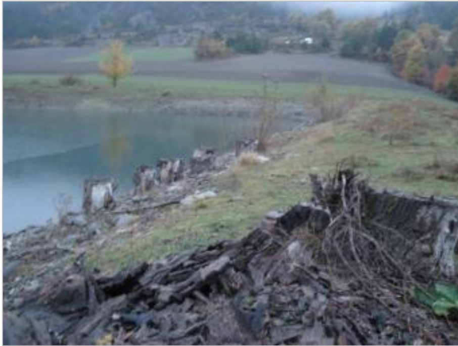
Figure 129. Souches en décomposition sur le couronnement amont et sur la crête de la retenue de P..P.. (France – 05) (photo : Mériaux P., 2014)
