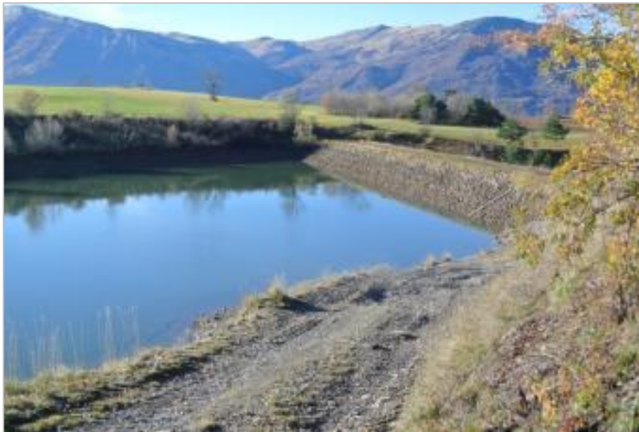
Figure 132. Vue du barrage des B... depuis l'amont (France - 05) (photo : Bambara G., 2014)
