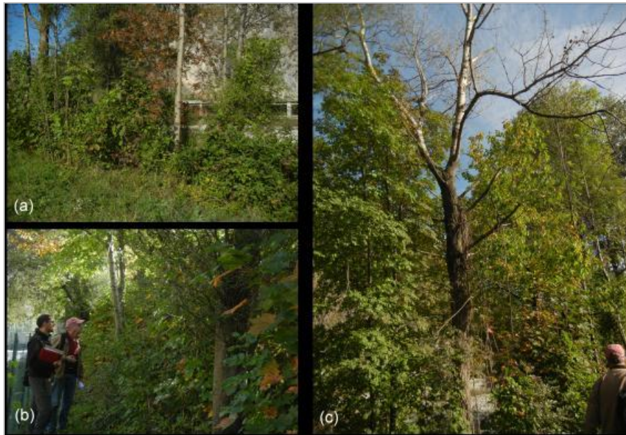
Figure 120. Profil choisi par le groupe d'experts pour l'évaluation de la performance du barrage vis-à-vis du mécanisme d'érosion (a : profil vu depuis la crête ; b : profil vu depuis le pied aval ; c : arbre mort sur le profil analysé) (photo : Bambara G., 2014)
