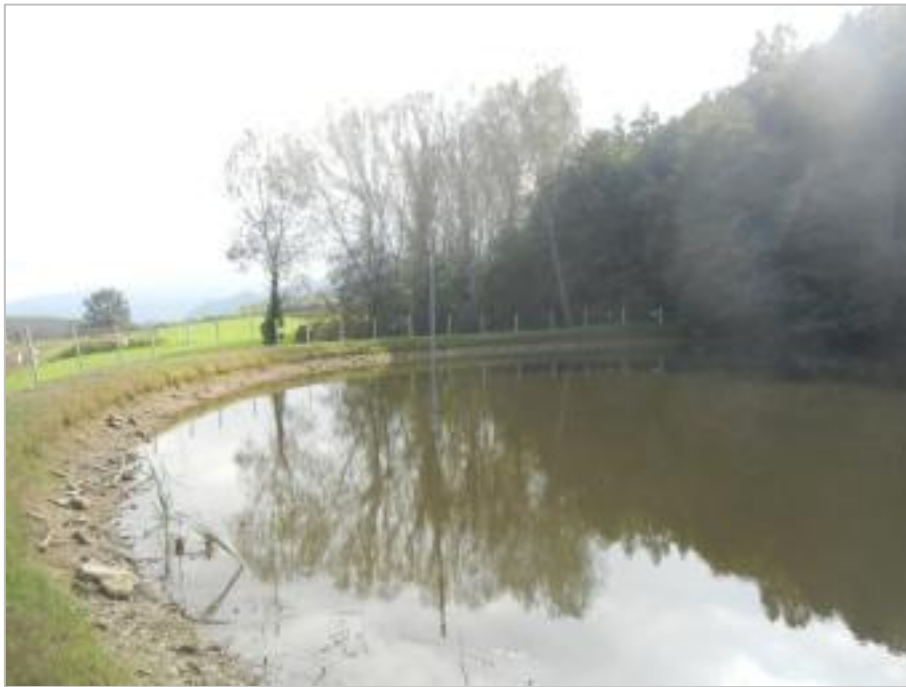
Figure 115. Vue depuis la crête du barrage d'O... (Italie) (photo : Bambara G., 2014)
