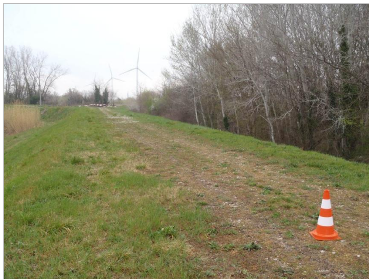
Figure 3. Tronçon aux caractéristiques homogènes de la digue de protection fluviale en remblai à Beaucaire-Fourques (13) (photo : Bambara G., 2012)
