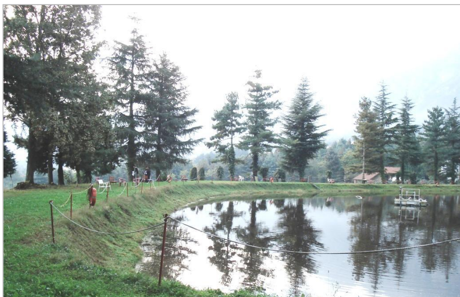
Figure 93. Répartition homogène des arbres sur le couronnement aval du barrage de Grengia, Italie (photo : Mériaux P., 2014)
