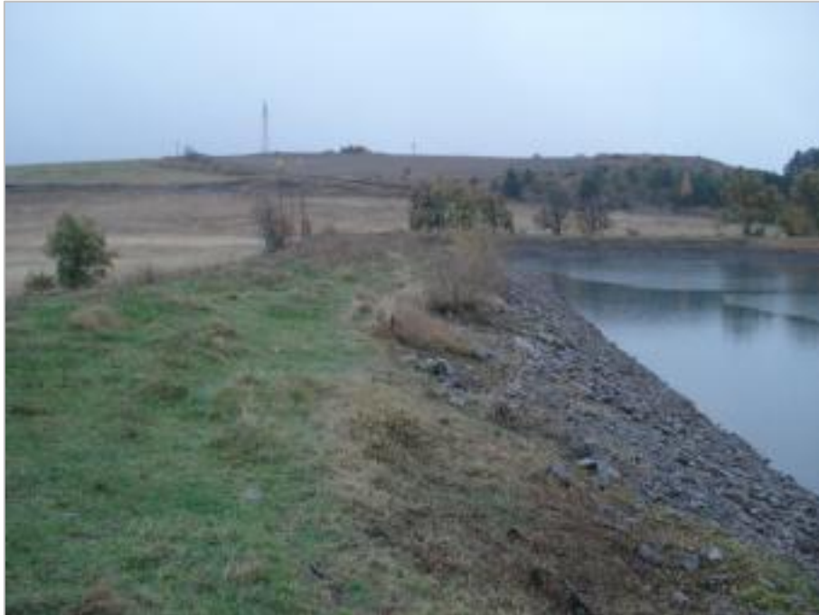
Figure 128. Vue de la retenue de P.. P.. depuis la crête (France – 05) (photo : Mériaux P., 2014)
