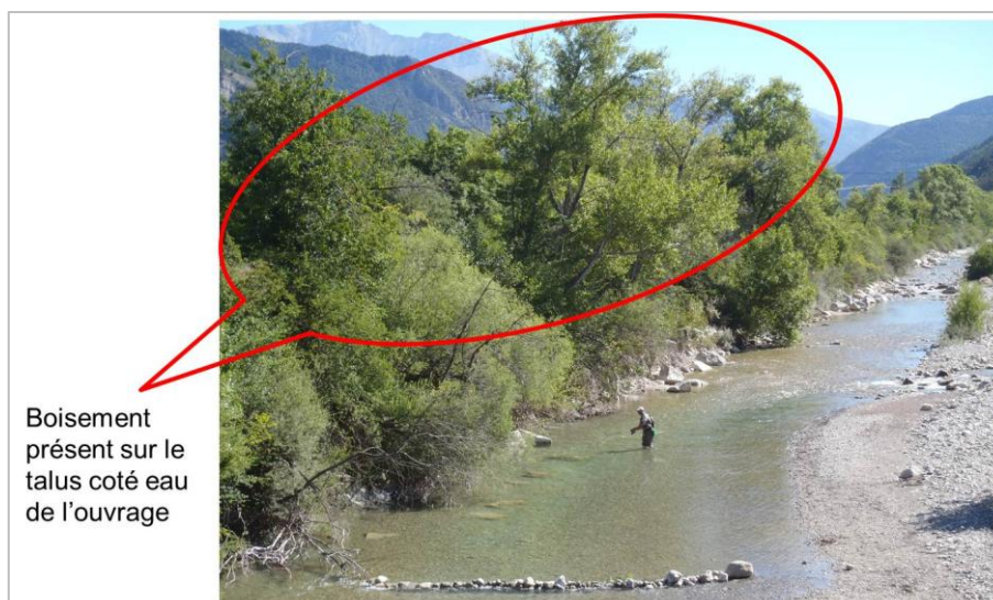
Figure 65. Vue du tronçon n°1 du talus coté rivière soumis à la présence d'une végétation arborescente de la digue de protection contre les inondations de Veynes (05) (photo : Bambara G., 2012)
