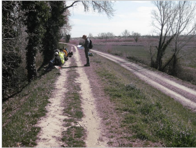
Figure 110. Photo de la digue du Petit Rhône dans le secteur du Mas de Cazeneuve. Vue de la végétation arborescente côté eau que les utilisateurs des modèles sont en train d'évaluer (Photo : Curt C., 2015)
