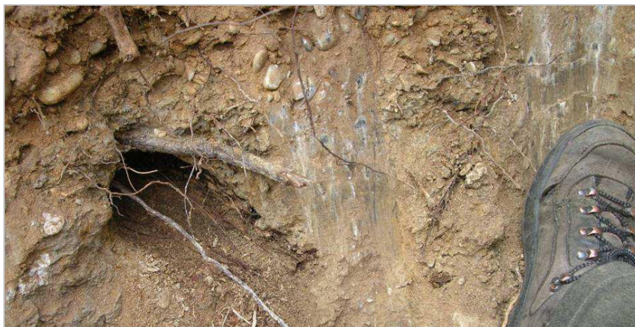
Figure 13. Exemple de conduit laissé par une grosse racine ligneuse après sa décomposition sur un ouvrage (photo : Zanetti, C.)
