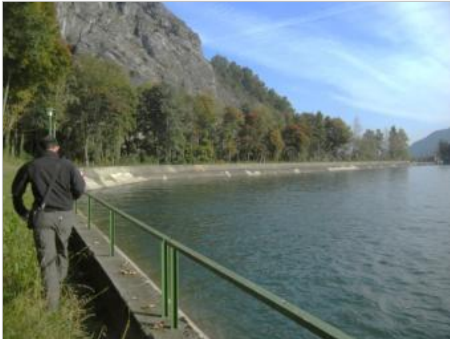
Figure 119. Vue depuis la crête du barrage d'A... (Italie) (photo : Bambara G., 2014)
