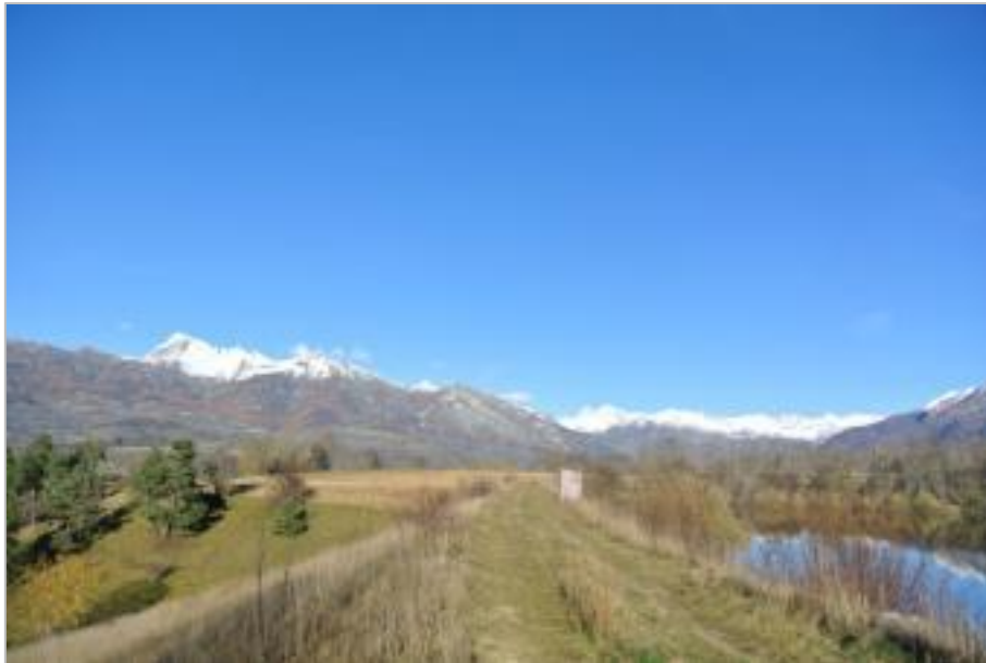
Figure 136. Vue du barrage des V... depuis la crête (France – 05) (photo : Bambara G., 2014)
