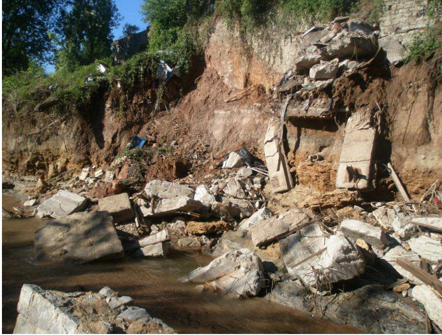
Figure 7-29 –L’ouvrage de la SNCF sur la commune des Arcs-sur-Argens vue en aval du pont.
