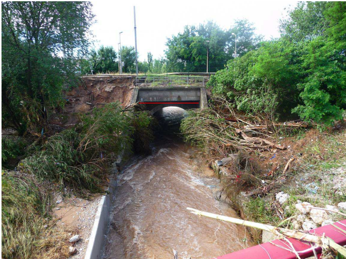
Figure 7-28 —L'ouvrage de la SNCF sur la commune des Arcs-sur-Argens vue en amont du pont. Les relevés topographiques ont montré que l'ouvrage n'a pas été submergé (droite rouge). La ripisylve proche de l'ouvrage témoigne des vitesses importantes d'écoulement. Le rétrécissement de la section constitue une section de contrôle et donc le passage en régime torrentiel. Les estimations de débit donnent une fourchette comprise entre 140 \text{ m}^3/\text{s} et 160 \text{ m}^3/\text{s} .
