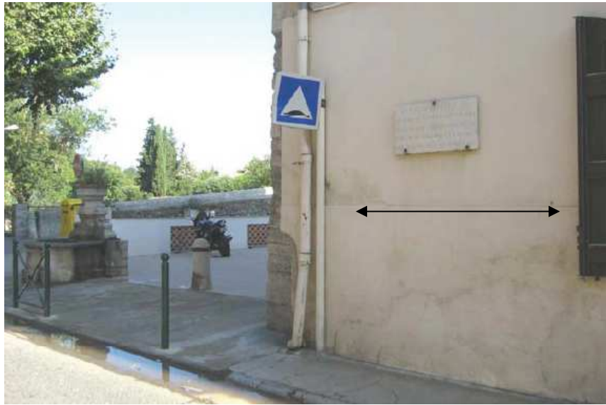
Figure 7-22 —Plaque commémorative de l'évènement du 6 juillet 1827 à Trans-en-Provence près du Pont-vieux. La flèche indique la laisse de crue du 15 juin 2010. (Source de C. Martin) On aperçoit à la gauche de la photo la rambarde du Pont-Vieux.
