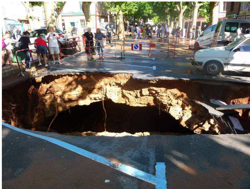
Figure 7-27 —La ville des Arcs-sur-Argens, le lendemain de la crue, au niveau du changement de section. Le Réal est canalisé dans sa partie amont dans deux buses puis en aval dans une section rectangulaire. La perte de charge créée au niveau du changement de section a entraîné un effondrement de la galerie. Selon, la notice technique éditée en 1977 par Caquot (Caquot 1977), les sections en aval doivent avoir au moins le même diamètre que la section amont quelle que soit la pente
