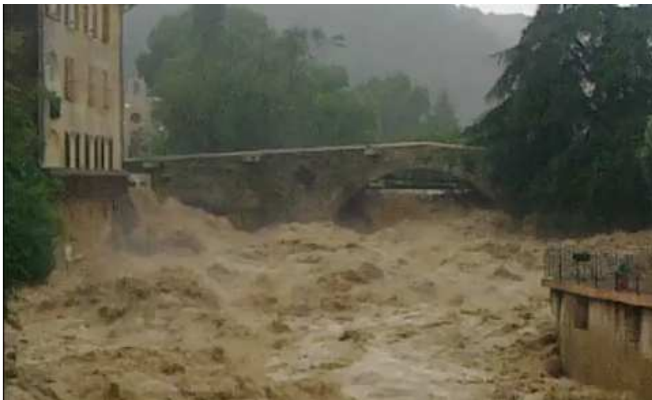
Figure 7-23 —Le Vieux-Pont situé dans la ville de Trans-en-Provence lors de la crue de la Nartuby le 15 juin 2010 vidéo filmée après 20 heures Sur cette vidéo on se rend compte de la violence de la crue. On note que la travée de droite du Pont-Vieux est en charge alors que celle de gauche à un tirant d'air de 1 à 2 m. L'eau s'est engouffrée dans la ville de Trans-en-Provence de chaque rive du pont (voir les laisses de crues sur la Figure 7-22). Selon certaines sources, l'eau aurait atteint le niveau de la terrasse photo à gauche ( http://www.youtube.com/watch?v=4cOhLVb_xWs&feature=related ).
