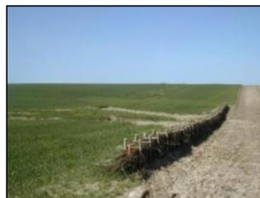
**FIGURE I-38: FASCINE PLACEE EN TRANSVERSALE PAR RAPPORT AUX ECOULEMENTS (SOURCE : FICHE SYNTHÈSE DE L'AREAS N°12)**
