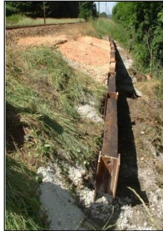
**FIGURE I-51: EROSION DU REMBLAI AVAL PAR PERCOLATION DANS LE CORPS DU REMBLAI**
