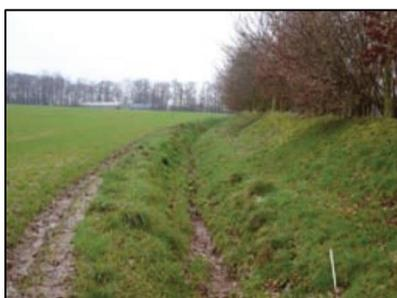
**FIGURE I-39: LES FOSSES ET TALUS REDIRIGENT LES ECOULEMENTS EN LES RALENTISSANT ET EN FAVORISANT L'INFILTRATION (SOURCE : FICHE SYNTHÈSE DE L'AREAS N°15)**
