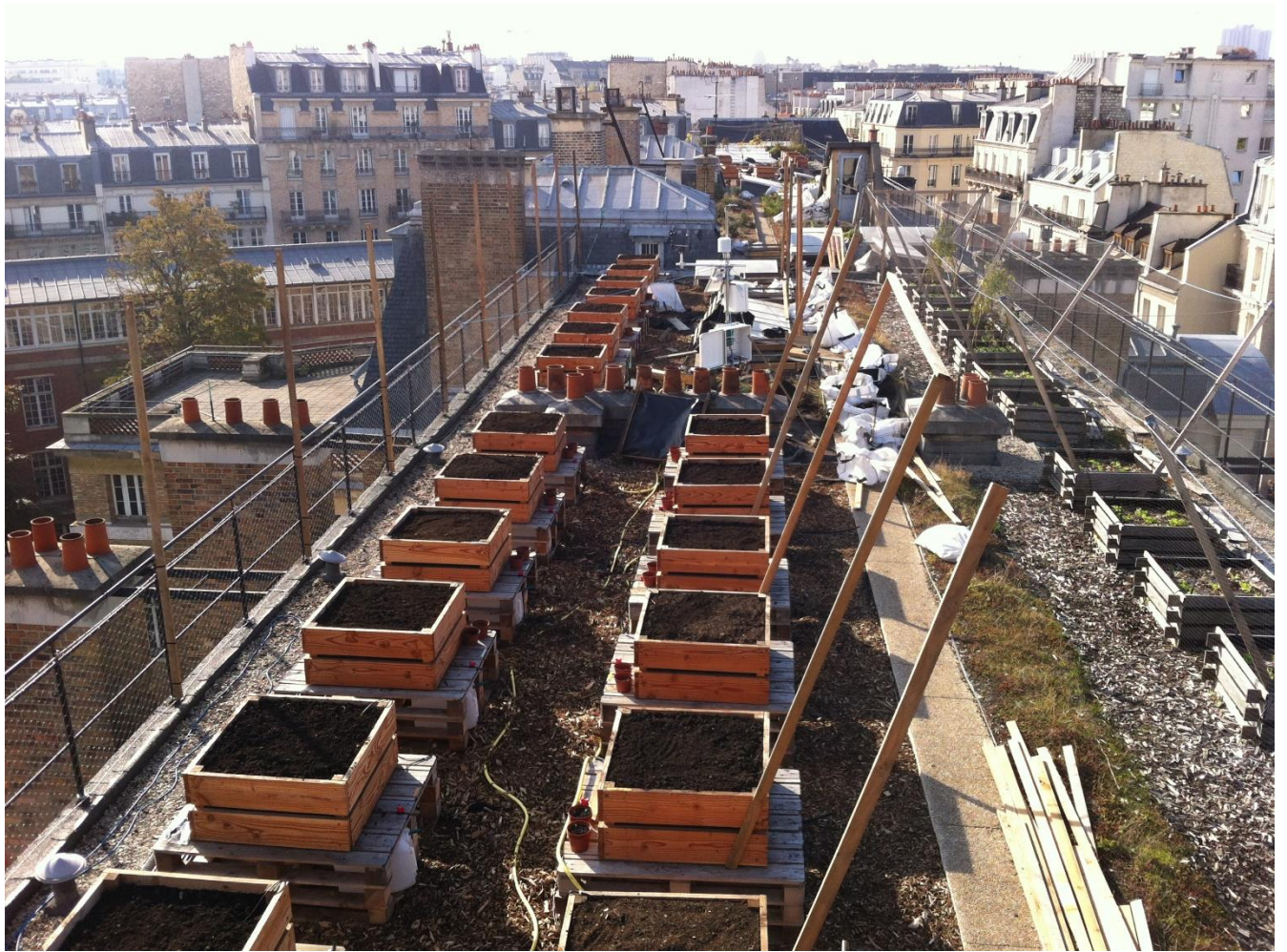
Toit d'AgroParisTech en octobre 2015 – lors de la construction du dispositif n°3. ©Baptiste Grard
