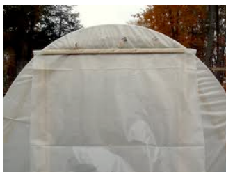
Installation de rideaux aux portes des serres
