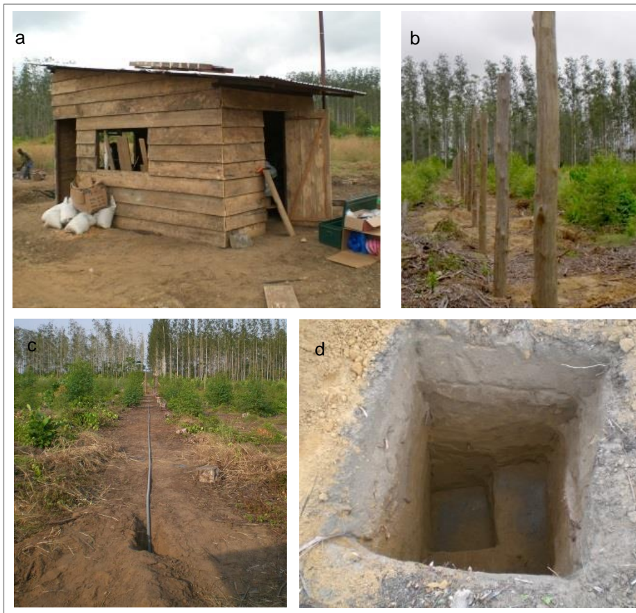
Figure 2.6 : Photo de la mise en place des infrastructures : a : cabane de gardien et local de rangement, b : installation des poteaux pour la clôture, c : câbles d'alimentations électrique et de communication entre centrales disposés pour être enterrés, d : fosse pour les mesures d'humidité du sol à différentes profondeurs.
