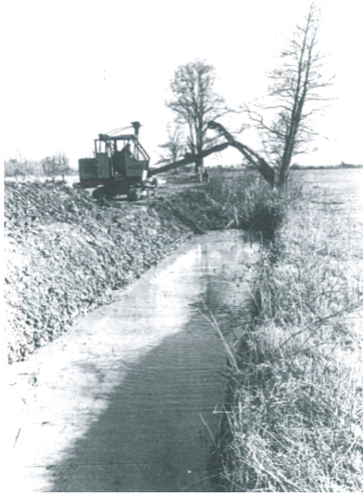
Figure 125. Construction d'un canal d'assainissement en plaine orientale. (Extrait de Lazzarotti, 1982)
