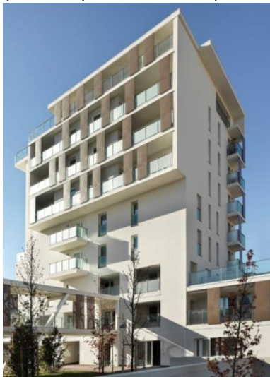
Figure 11 : Immeubles bois en panneaux de bois lamellé croisé (CLT)
