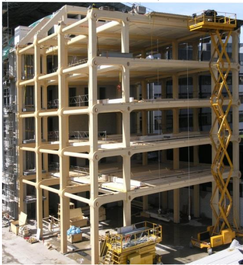
Figure 10 : Bâtiments multiétages en poteaux-poutres bois
