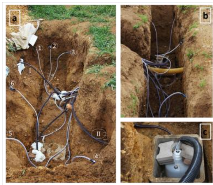
Figure II.2112- Installation des équipements de collecte d'eau : (a) fosses d'installation des lysimètres à mèche et bougies poreuses (1 à 6 bougies poreuses et I à II lysimètres à mèche), (b) drain au milieu de la fosse, et (c) bidon de 23 L pour collecter l'eau provenant du lysimètre placé dans un regard en béton.
