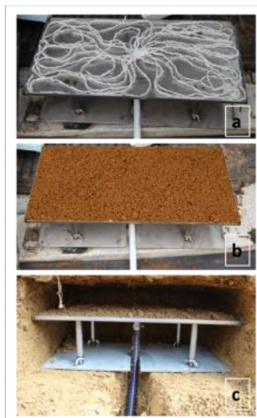
Figure II.20 - Lysimètres à mèche en cours d'installation : (a) mèche en fibre de verre disposée à la surface du lysimètre, (b) la surface du lysimètre à mèche est ensuite recouverte avec du sol tamisé avant le positionnement dans le profil pour assurer un bon contact entre la mèche et le sol sus-jacent, et (c) positionnement du lysimètre dans le profil du sol, le lysimètre étant ensuite mis en contact avec le sol sus-jacent au moyen de 4 verrins.
