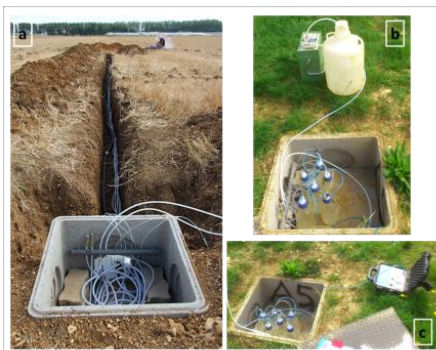
Figure II.22- Collecte de l'eau du sol : (a) regard en béton en cours d'installation en bordure de parcelle à 15-20 m de la fosse, (b) pompe péristaltique et bidon de 23 L pour la collecte de l'eau provenant des bidons enterrés connectés aux lysimètres, et (c) pompe à vide pour la mise en succion des 6 bougies poreuses au moyen des flacons collecteurs de 1 L.
