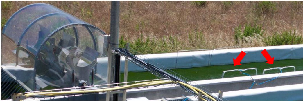
Emplacement des deux unités de transferts de CO 2 dans la lagune
