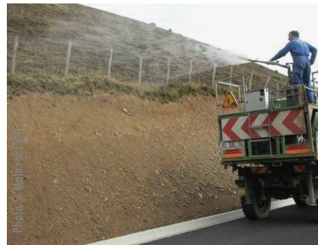
Figure 2 : restauration d'un talus par semis hydropropulsé (hydroseeding)
