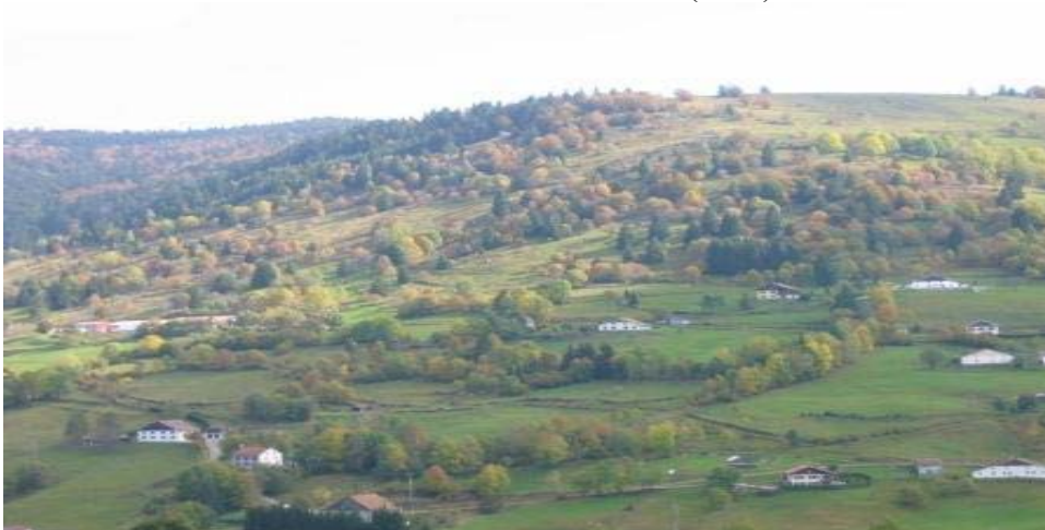
Photo n° 14 : Construction de chalets sur des terrains agricoles de fond de vallée (2005)
