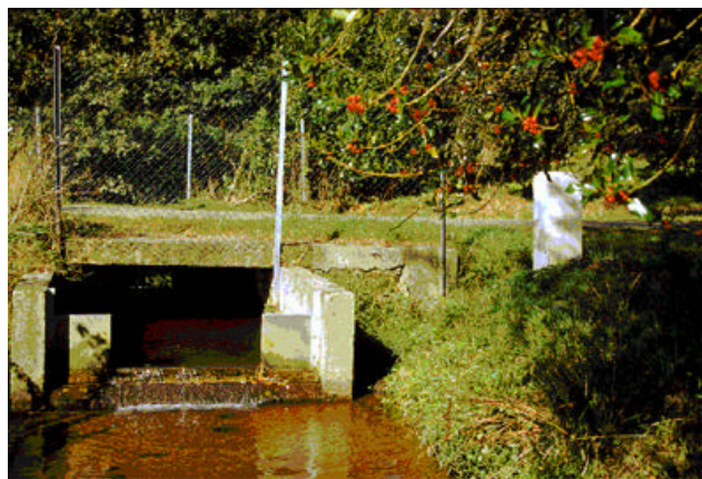
Fig. 15 - Station limnimétrique de Kervidy sur le Coët Dan-Naizin.
