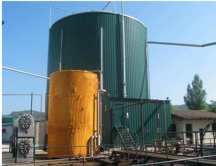
Figure VII-14 : Réacteur industriel (en bleu-vert) et son réacteur tampon (jaune) d'Agralco.
