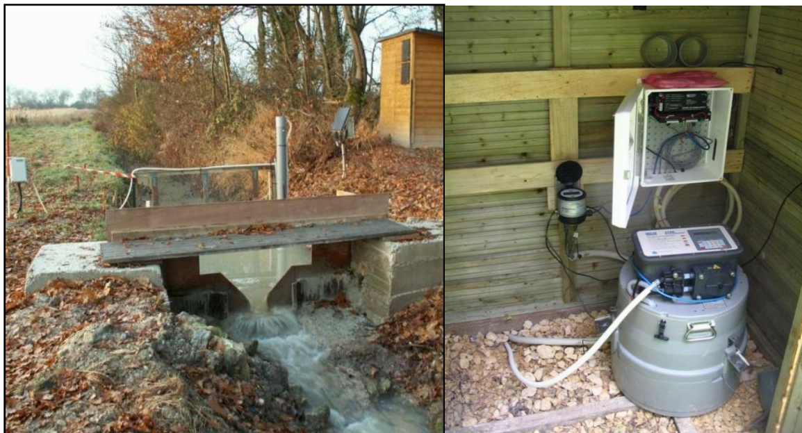
Station de mesure sur l'expérimentation de Villedomain (37) : section de contrôle et préleveur automatique
