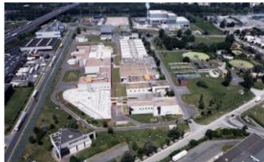
Biofiltration (Saint-Thibault-des-Vignes, 350 000 PE)
