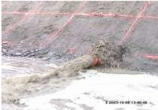
Début du piping flow erosion (t=0)
