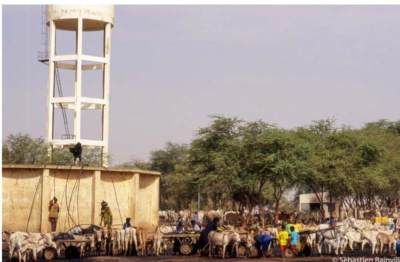
PHOTO 3-7 : REMPLISSAGE DES TONNES A EAU
