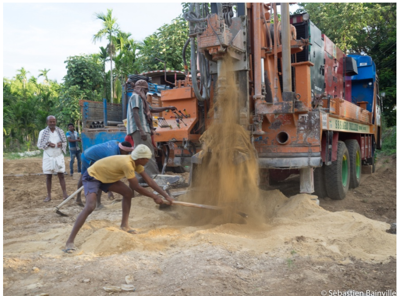
PHOTO 5-14 : FONÇAGE D'UN FORAGE – CHANNAGIRI (KARNATAKA)
