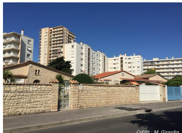
Figure 41 : Morphologie du bâti de Saint-Martin (juin 2019) : pavillonnaire au premier plan, grands ensemble au second avec le Tour Saint-Martin en fond
