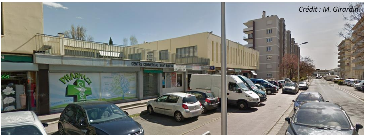
Figure 42 : Centre commercial Saint-Martin en juin 2019
