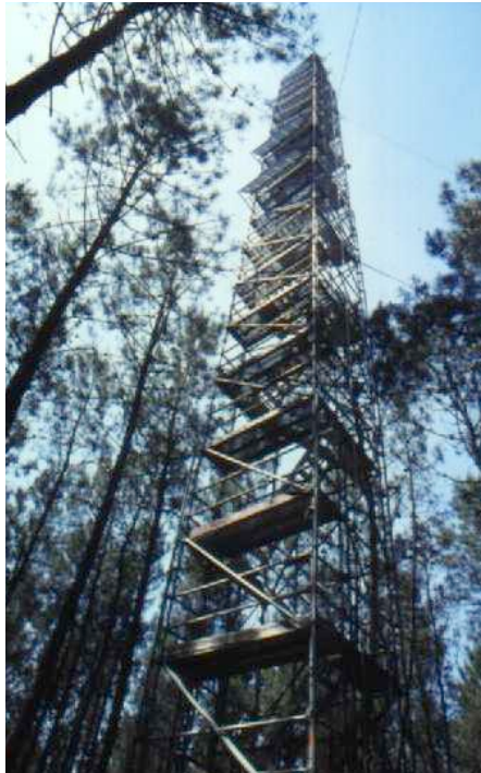
Figure 4 : tour de mesure de 40 m au site du Bray.
